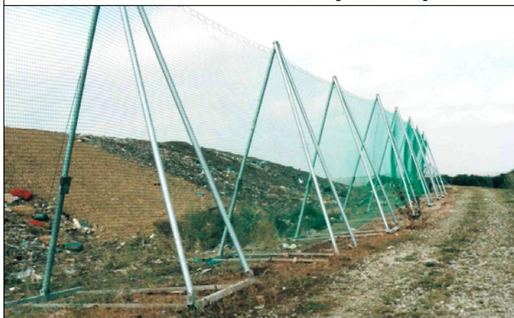
Abb. 2: mobile Fangzaunanlage, verstärkte Ausführung Höhe 4 - 6 m; bis 120 km/h Windgeschwindigkeit
